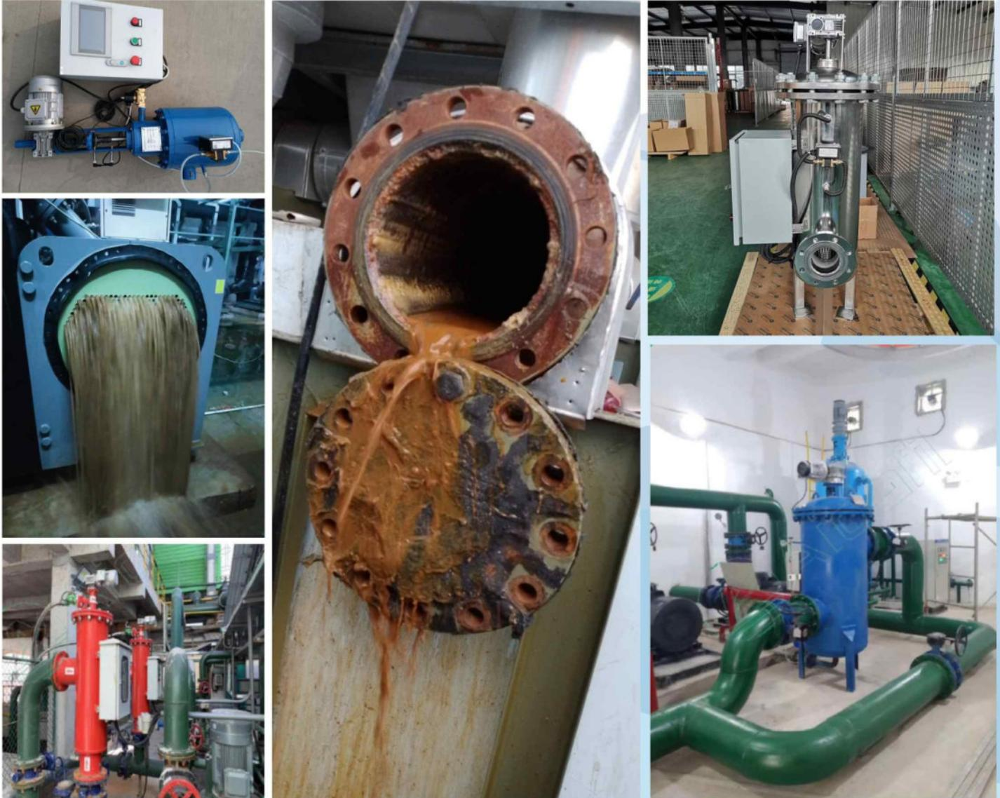
Filter air self-cleaning bekerja dengan menggunakan teknologi khusus untuk membersihkan air dari kotoran dan partikel yang tidak diinginkan. Filter ini dirancang untuk mempertahankan kinerja yang optimal tanpa perlu membersihkannya secara manual.
